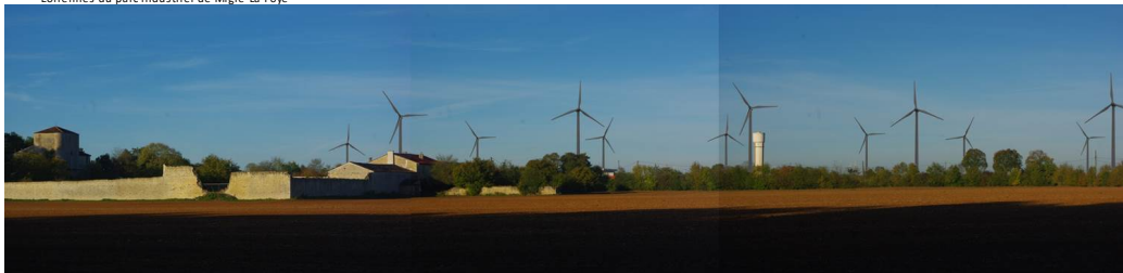
Photomontage N°7 - Parc industriel éolien de Villeneuve la Comtesse - Vergné en arrière-plan du château de Villeneuve la Comtesse. Vue depuis l'est du château.
